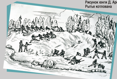
Рисунок юнга Д. Арсенина. Рытье котлована
